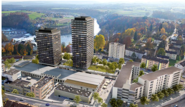
RhyTech-Quartier, Neuhausen am Rheinfall Planung & Ausführung Gesamtprojekt Gebäudetechnik
