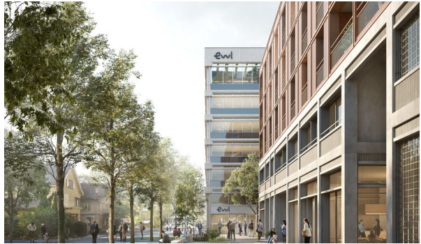
EWL Areal, Luzern Planung & Ausführung Gesamtprojekt Gebäudetechnik
