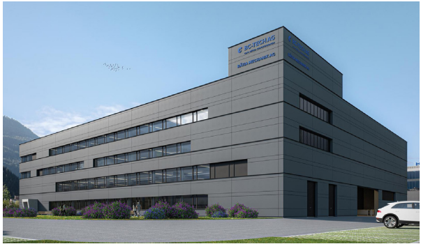
BC-Tech AG, Domat Ems Planung & Ausführung Gesamtprojekt Gebäudetechnik
