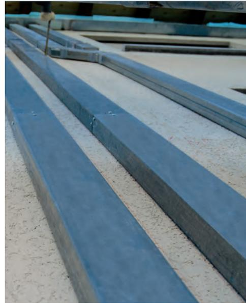
Die Zuluftkanäle sind in die nachträglich aufgebrachte Wärmedämmung integriert.
