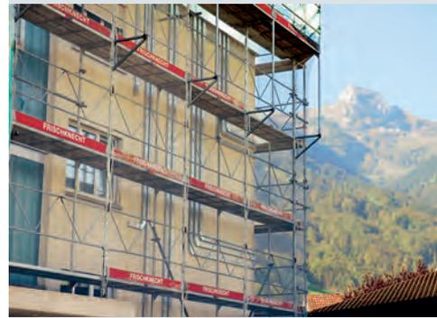
Die Montage der Zuluftkanäle von aussen sorgt für eine geringe Störung der Bewohner während der Sanierungsausführung.
